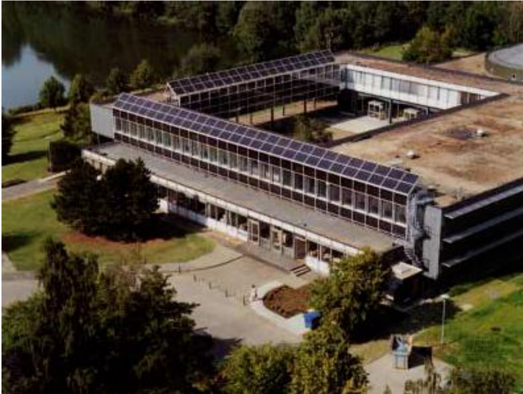
Bild 10 : PV-Anlage auf Flachdach (Bibliothek des Forschungszentrums Jülich)
